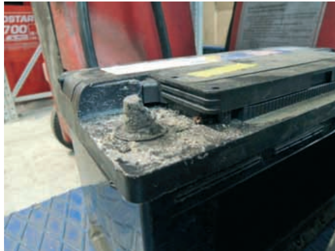
Baterie s poškozenými póly. Zřetelné usazeniny!
